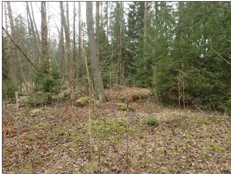
Rakennuksen perusta pohjoisesta (suuren haavan ja kuusinäreiden välissä).
